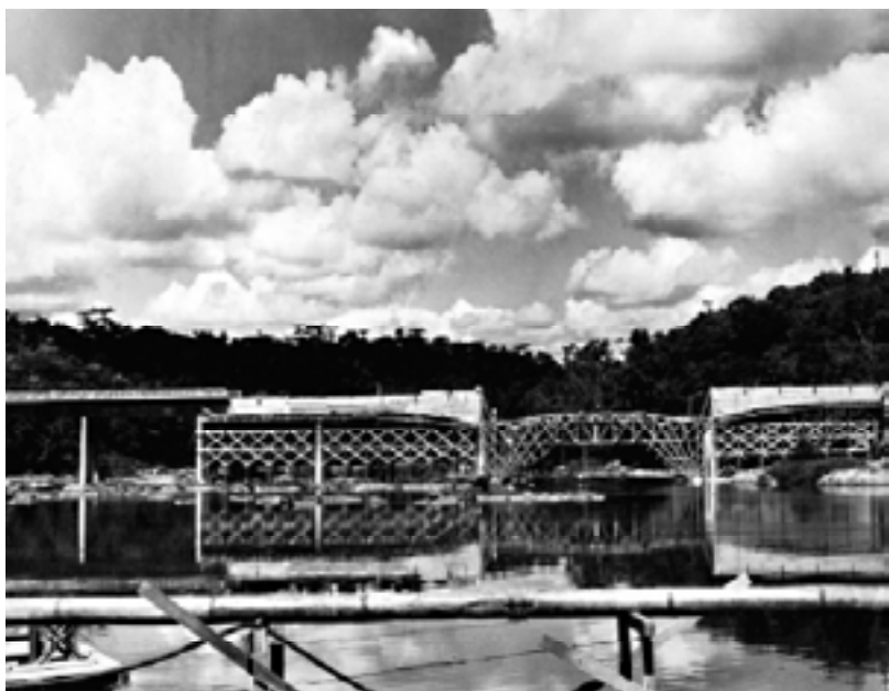
Construção da ponte sobre o rio Tibagi, década de 1940.
