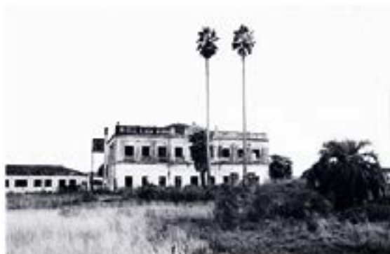
Figura 4 - Ruínas Vila Santa Thereza, antigo casarão do Visconde, onde residia na Vila Santa Thereza.
