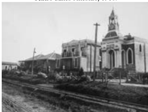
Figura 2 - Capela de Santa Thereza D'Ávila, ao lado está o Teatro Santo Antônio, 1910.
